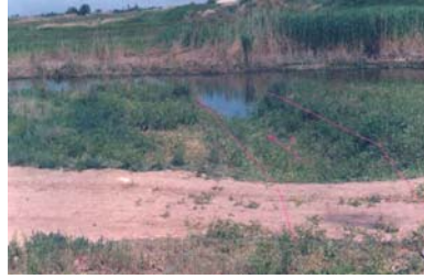
Նկար 3 - Ռանչպար գյուղական համայնքում ոռոգման ջրանցքից ջրի արտահոսքի պատճառով Սևջուր գետի ափամերձ գրունտային ճանապարհի ջրային էրոզիայի հետևանքով վնասման պատկեր
