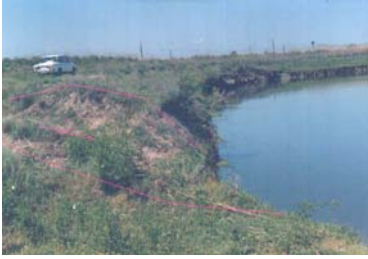
Նկար 2 - Ռանչպար գյուղական համայնքում ոռոգման ջրանցքից ջրի արտահոսքի հետևանքով Սևջուր գետի ափամերձ հատվածի ծորակագոյացման պատկեր
