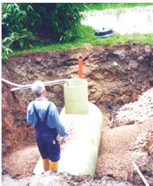
Рис. 4.15 Емкость для хранения мочи и ветланд, созданный для очистки «серой воды» и фильтрата сепараторной секции в Ламберсмухле.
