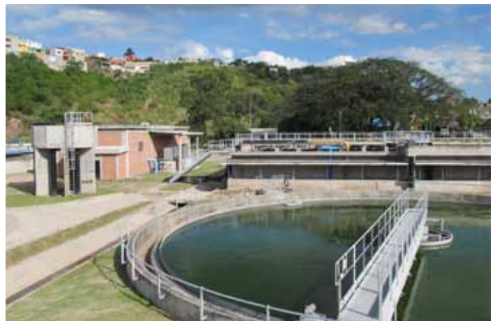
Planta de tratamiento de aguas residuales de Tegucigalpa, Honduras.
