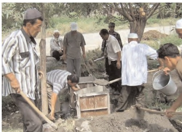
Рисунок 15. Строительство водомерных сооружений на уровне АВП, Кыргызстан
