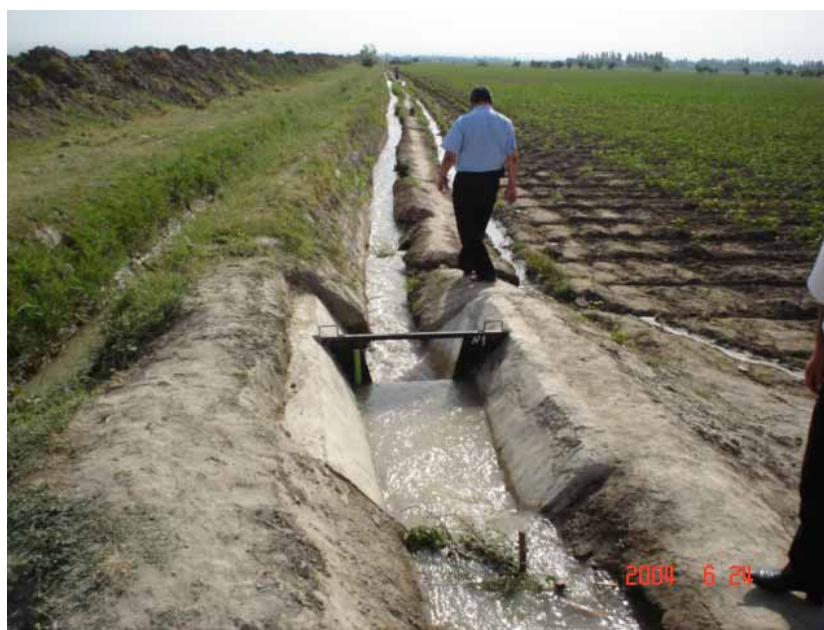
Рис. 15. Водослив для учета воды, подаваемой фермеру (АВП «Заравшан», Таджикистан) (фото В.И. Соколова)
