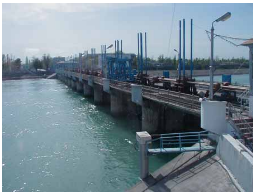
Рис. 14. Учкурганский гидроузел на реке Нарын – оборудованный в 2003 году системой SCADA в рамках проекта, финансируемого SDC (фото Полтарева Г.)
