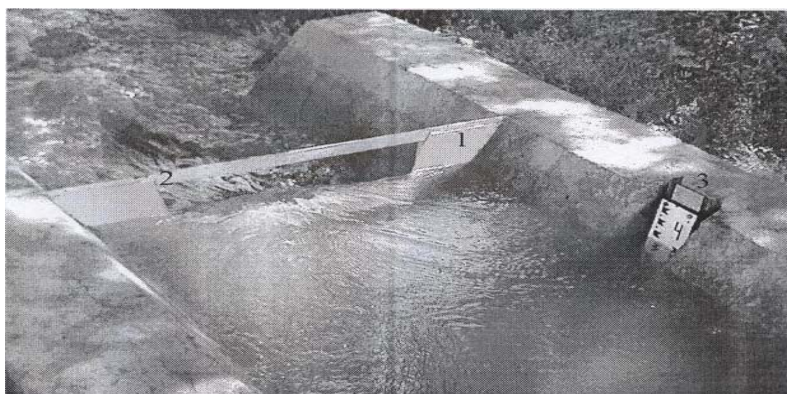
4-расм. Трапециясимон водослив. 1) ЧВ-50 водосливи; 2) маҳкамлаш қирраси; 3) сатҳўлчагич ўрнатилган тинчлантириш чуқурчаси.
