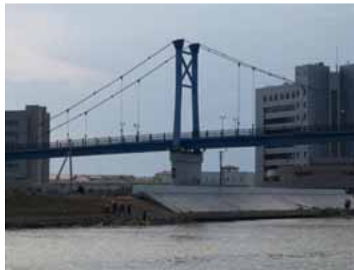
Работы по обустройству берегов реки Урал в г. Атырау
