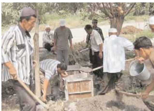
Рисунок 15. Строительство водомерных сооружений на уровне АВП, Кыргызстан
