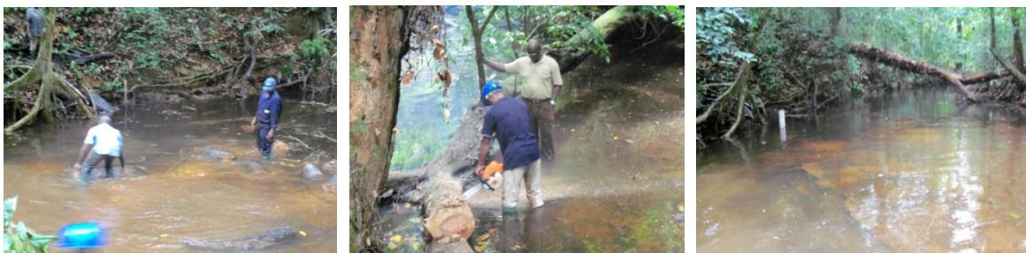
Figure 56 : Installation de la station limnimétrique d'Eboundja
