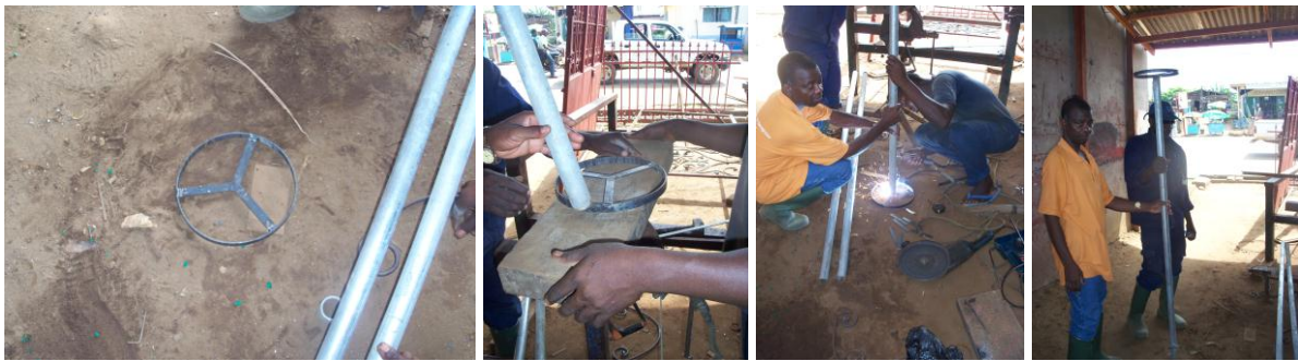
Figure 46 : Fabrication d'un support de pluviomètre
