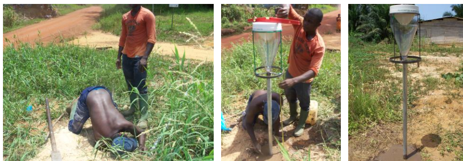
Figure 47 : Installation du pluviomètre à lecture directe à Eboundja
