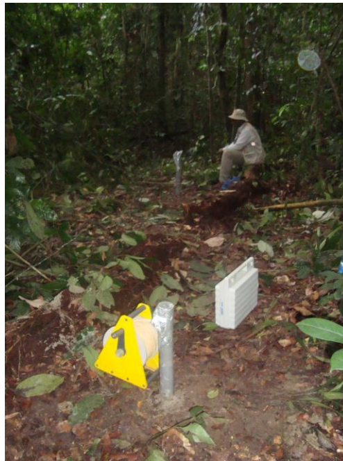
Figure 55 : Dispositif de suivi d'une batterie de piézomètres et de mesures des paramètres in situ
