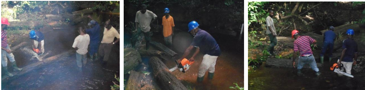
Figure 48 : Travaux de déblayage lors de l'installation d'une station limnimétrique
