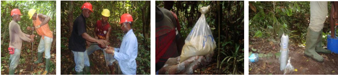
Figure 53 : Fonçage à la tarière, collecte de cuttings et équipement des piézomètres
