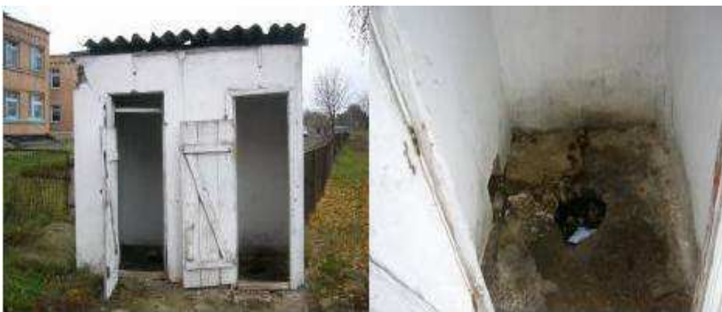
Obrázek 4.7: Staré školní záchody v obci Gozhuly: zvenku (vlevo) a zevnitř (vpravo).
