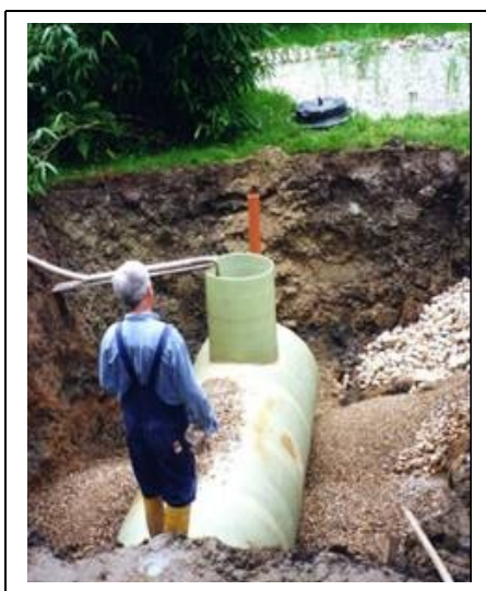
4.15. ábra: Vizelet-tartály és épített vízínövényes rendszer a szűrkevíz és az elválasztó egységből származó szűrlet tisztítására Lambertsühle-ben.
