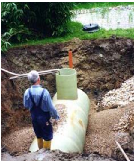
4.15. attēls Urīna tvertne un mākslīgais mitrājs “pelēkā ūdens” un sadalīšanas bloka filtrāta attīrīšanai Lambertsmīlē.
