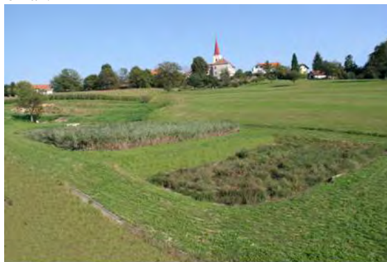
Rysunek 4.1. Oczyszczalnia hydrofitowa Sveti Tomaž
