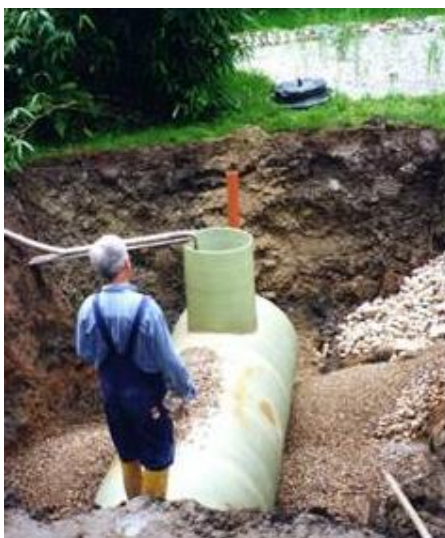
Figura 4.15. Bazinul cu urină și zona umedă construită pentru epurarea apei gri și a levigatului din instalația de separare din Lambertsühle.
