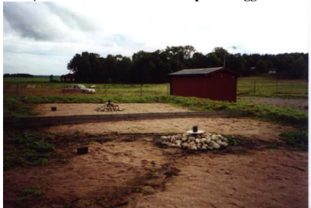
Căsuța 4.3: Filtrul deschis cu nisip din Lagga
