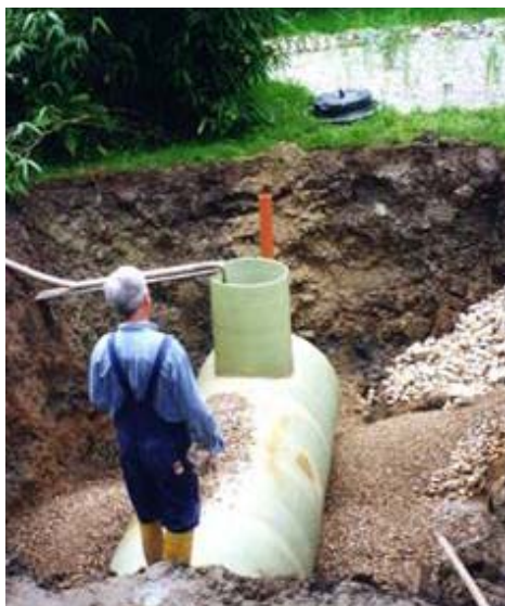
Obrázok 4.15. Nádrž na moč a umelá mokrad' pre čistenie šedých vôd a priesakov zo separácie v Lambertsühle.
