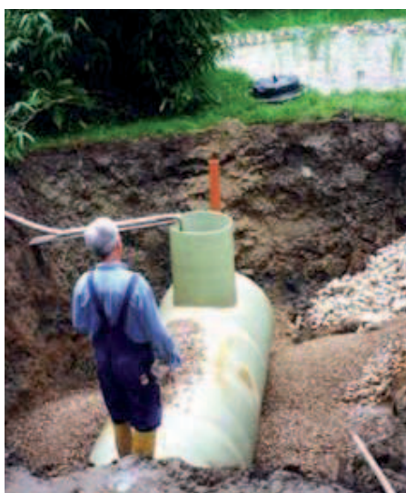
Малюнок 4.15. Тенк для сечі та штучні ветланди для очистки сірих стоків та фільтрату з камери для розділення у Ламбертсмюхле.
