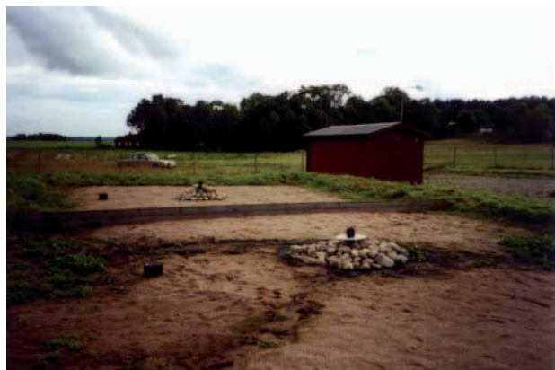
Вставка 4.3. відкритий піщаний фільтр
