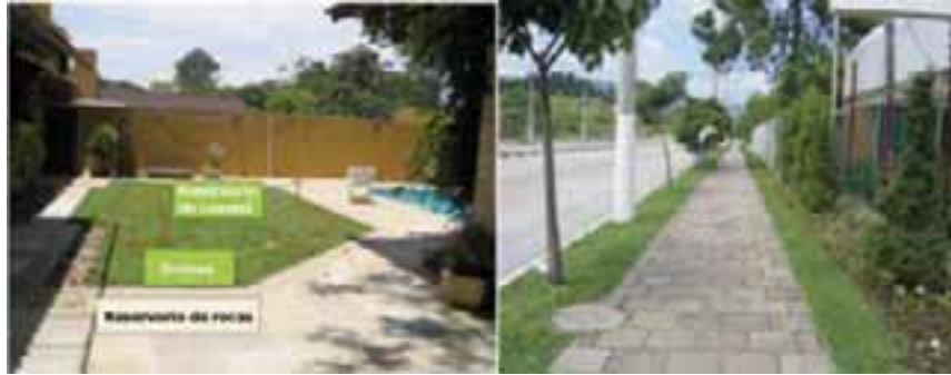
Figura 3.22. Uso de dispositivos para retener el agua de áreas impermeables (a) la foto a la izquierda muestra las áreas drenadas de pavimentos para el césped y de los tejados para los reservorios de piedra: (b) veredas con céspedes en las laterales para aumentar la infiltración.
