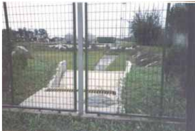
Figura 6.22. Cuenco de detención ejecutado en un emprendimiento privado. Córdoba, Argentina (Fuente: Toya et al. , 2003).
