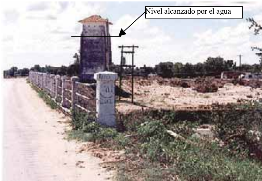
Figura 6.43. Sector inmediato aguas arriba del puente. Evento de enero de 1992 en San Carlos Minas, Argentina (Fuente: Barbeito et al. , 2004).
