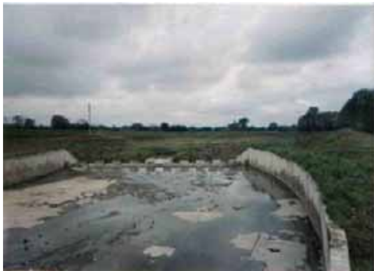
Figura 6.24. Cuenco de detención de grandes dimensiones ejecutado en un sector público.
