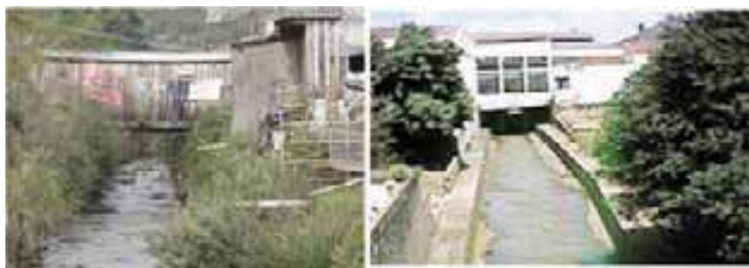
Figura 3.10. Construcciones en el drenaje (Caxias do Sul- Brasil)
