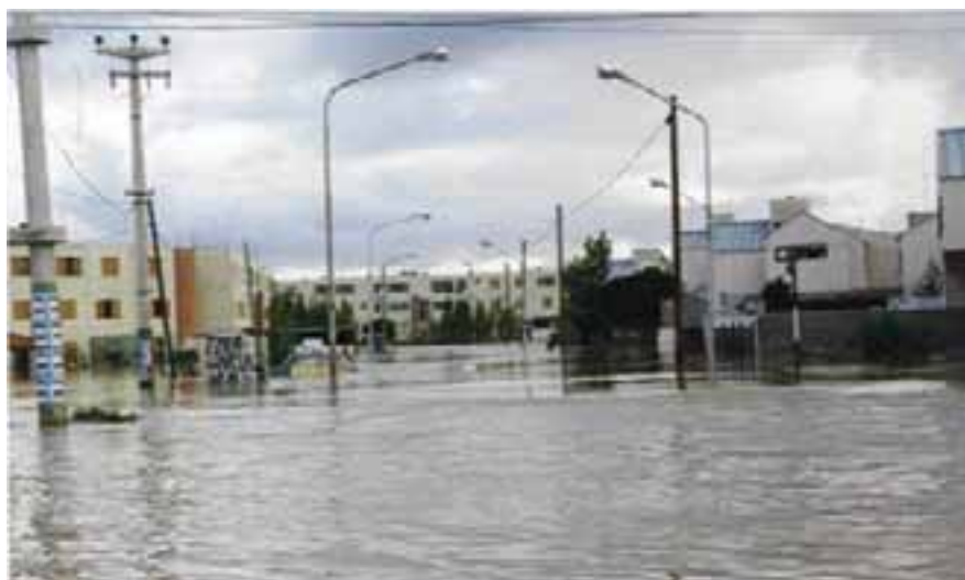
Figura 6.41. Imagen del Sector Mil Viviendas, dentro del Sistema del Cañadón del Parque Industrial, Trelew, durante la tormenta extraordinaria del 24/25 de abril de 1998.
