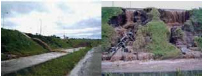
Figura 6.27. Deterioros del canal externo durante la tormenta de diciembre de 2003. Situación anterior y posterior al pico de la crecida.
