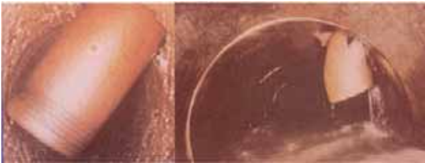
Figura 6.55. Tuberías empotradas directamente en los conductos de drenaje pluvial. (Fuente: Cruz y Molina, 2004).
