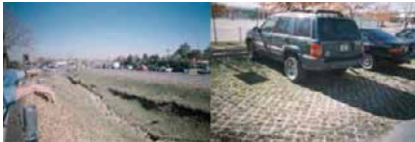
Figura 3.23. La foto a la izquierda muestra un ejemplo de trincheras de infiltración y la foto a la derecha muestra pavimento permeable con bloques perforados en estacionamientos.
