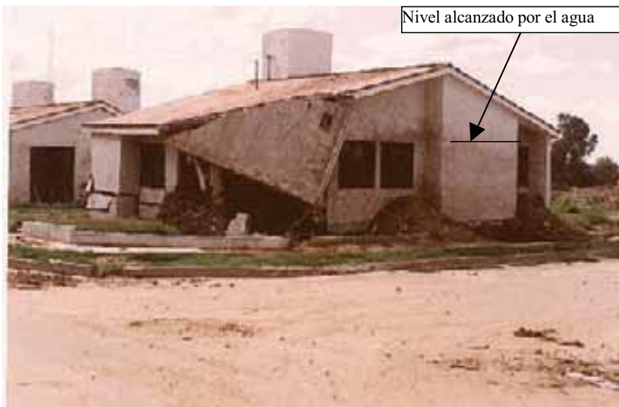
Figura 6.44. Daños sobre viviendas en un barrio de San Carlos Minas, Argentina. Inundación de enero de 1992.
