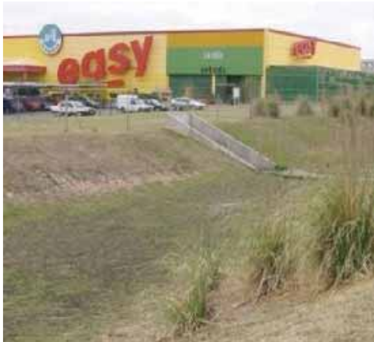
Figura 6.23. Cuenco de detención ejecutado en un emprendimiento comercial privado. Córdoba, Argentina (Fuente: Toya et al. , 2003).
