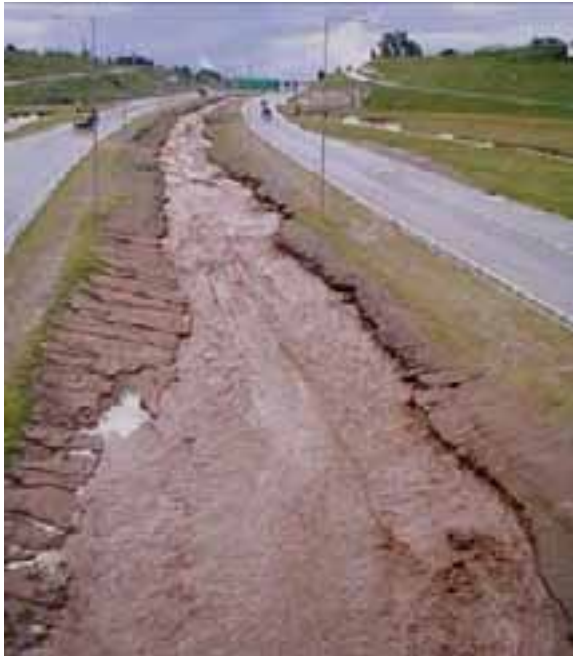
Figura 6.30. Estado del canal central del Arco Noreste luego de la tormenta de diciembre de 2003.
