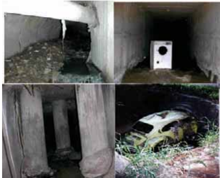
Figura 3.7. Obstrucción y residuos en el drenaje (Belo Horizonte y São Paulo – ciudades de Brasil)
