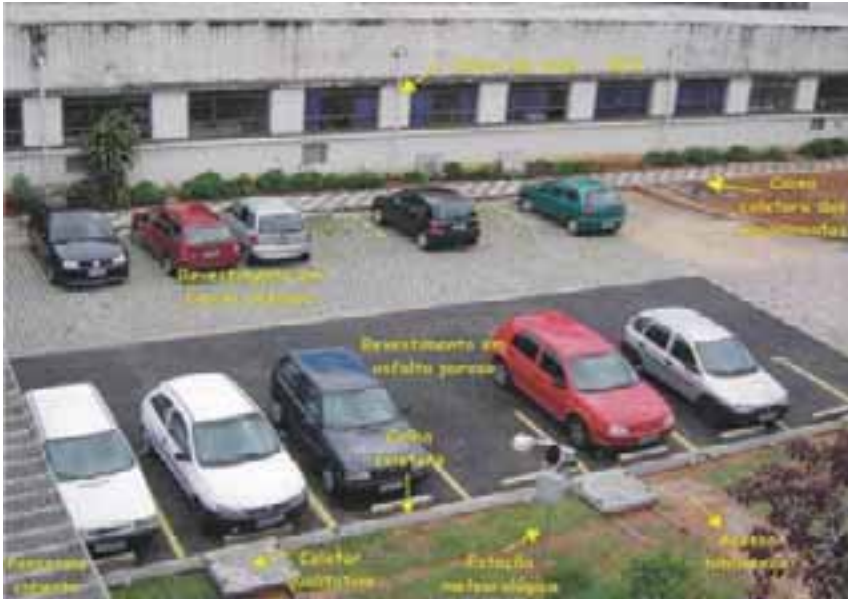
Figura 3.25. Dos áreas experimentales en el estacionamiento del Instituto de Pesquisas Hidráulicas (Porto Alegre – Brasil) con bloque perforado y asfalto poroso.
