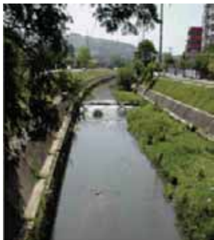
Figura 3.9. Obstrucciones al escurrimiento en canales (Porto Alegre- Brasil).
