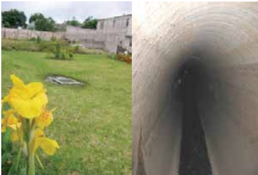
a. vista de una de las cámaras de acceso al dispositivo regulador.
