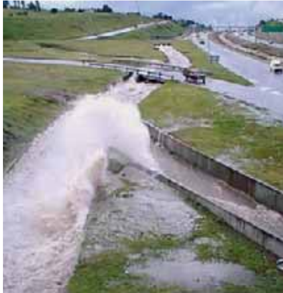
Figura 6.29. Canal interno durante la tormenta de diciembre de 2003. Obsérvese el efecto producido por el inadecuado proyecto hidráulico de la transición.
