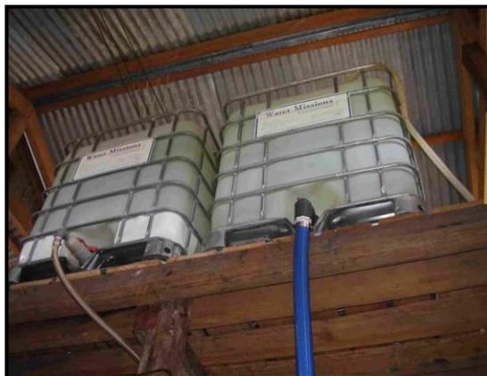
**Figura 17.** Tanques de almacenamiento del agua potable, listos para su distribución.
