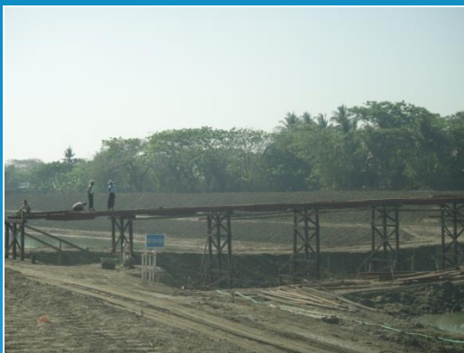
RD 58+000 Kha Naung Paw and Lay Ein Su Village Bridge
