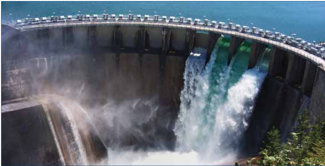
Presa Kerr en el río Flathead, EE.UU.
