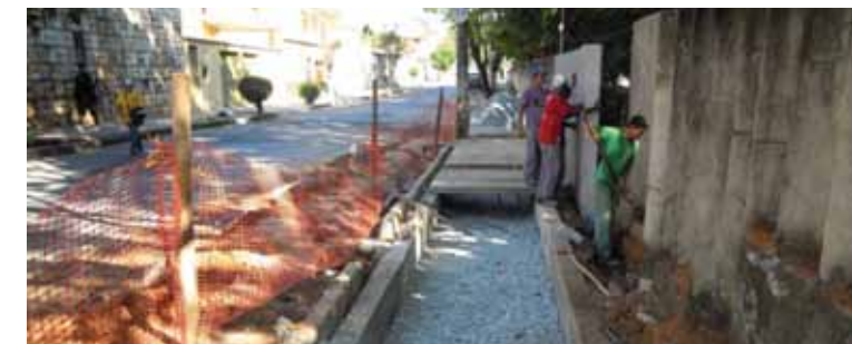
Stormwater infiltration trench in Belo Horizonte (Nilo Nascimento).
