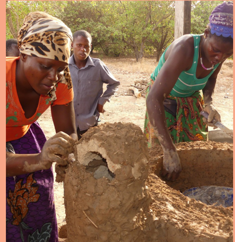
Formation à la construction de foyers améliorés par les femmes
