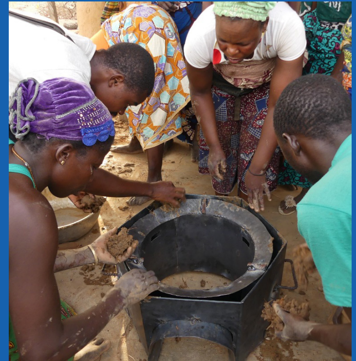
Installation d'un foyer amélioré dans le village de Yakabissi (Kouandé)
