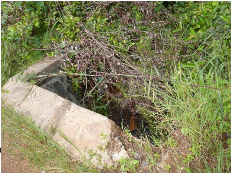
**Kobongwé** : Sur ce cours d'eau, un dalot double a été aménagé. Une déviation a également été aménagée pour le franchissement de ce cours d'eau pendant les travaux. Le cours d'eau qui été dévié pour permettre le déroulement des travaux n'est pas encore restitué dans son lit.
