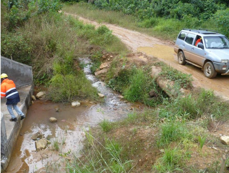
**Mbobingwé** : C'est un cours d'eau permanent sur lequel un pont en maçonnerie de moellons est en cours d'exécution. Une déviation en matériaux provisoire a été aménagée pour le franchissement du talweg. Il représente la limite Sud de la zone de terrassement.
