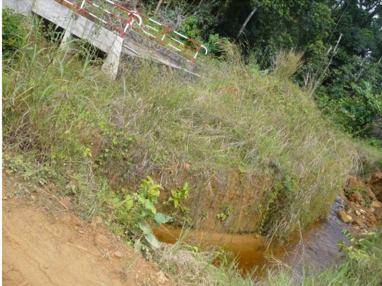
**Petit Kobongwé** : C'est un cours d'eau sur lequel un pont en maçonnerie de moellons est en cours d'exécution. Une déviation en matériaux provisoire est en cours d'aménagement, mais ne présente pas de bonnes garanties par rapport au passage des engins lourds tels que ceux destinés aux travaux de terrassement.
