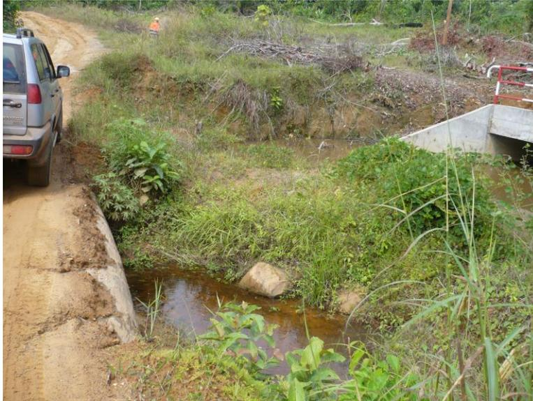
**Bekogno** : c'est un cours d'eau saisonnier sur lequel on a construit une buse. Ce cours d'eau permet de drainer la zone inondable et marécageuse située en amont.
