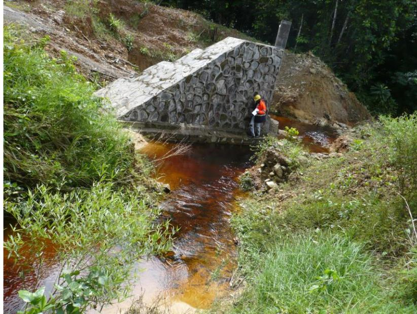
**Dibète (Mébéra) :** c'est un cours d'eau sur lequel un pont dont les culées sont en maçonnerie de moellons est en cours de construction. Une déviation a été également aménagée pour permettre le franchissement pendant la durée des travaux.
