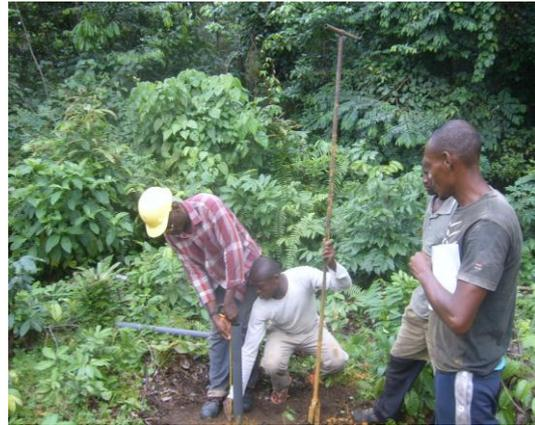
Ces piézomètres sont ensuite équipés des tuyaux en PVC crépinés sur toute la hauteur mouillée. le piézomètre ainsi réalisé est bouché pour éviter toute entrée de l'eau ou chute d'objet à l'intérieur du tubage (Photo). Pour chaque piézomètre implanté, les informations suivantes sont notées :
