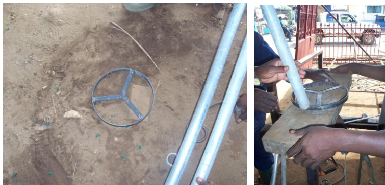
Figure 44 : Fabrication du support galvanisé
