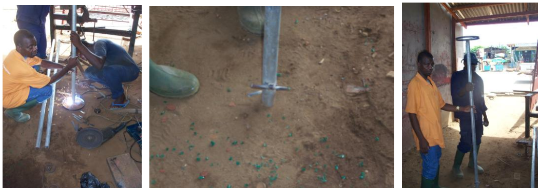
Figure 45 : Fabrication du support galvanisé
