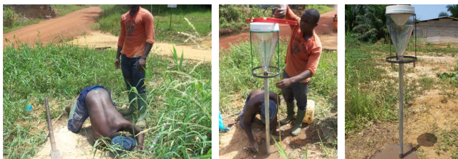
Figure 46 : Installation d'un pluviomètre à lecture directe
