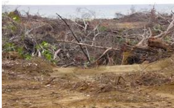
Figure 116 : Déblayage au niveau du port
