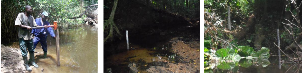
Figure 48 : Installation de la station limnimétrique de Lolo aval
