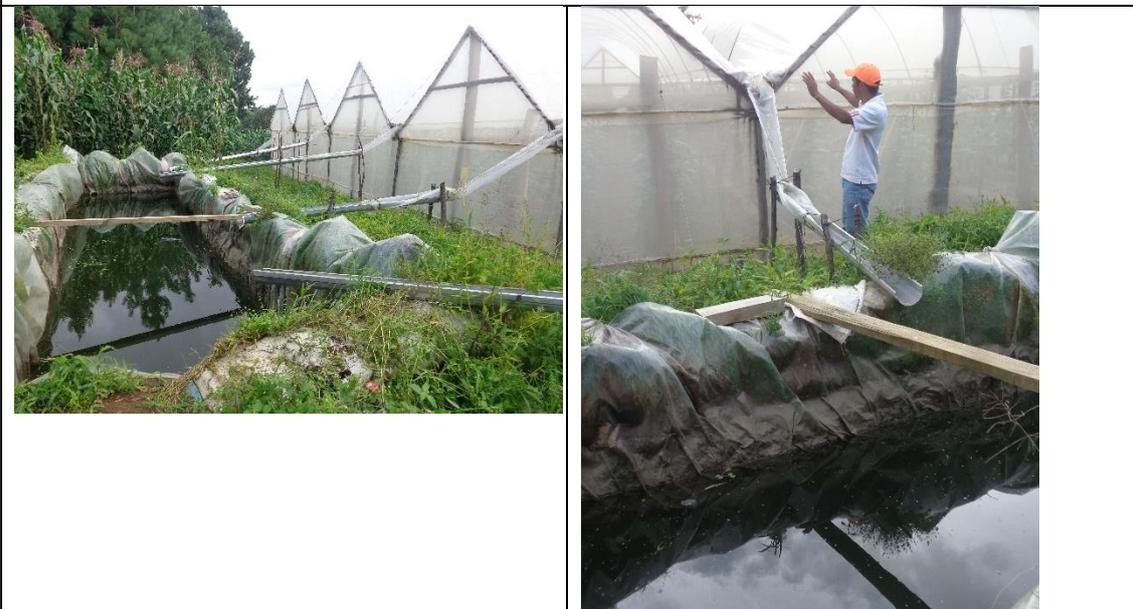
Captación de agua de lluvia de los invernaderos para sistema de riego por goteo
