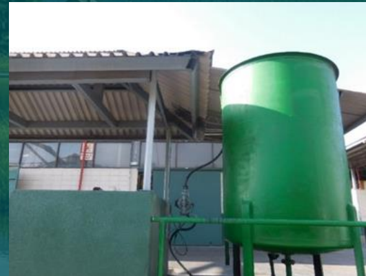
Recuperación agua de rechazo osmosis
