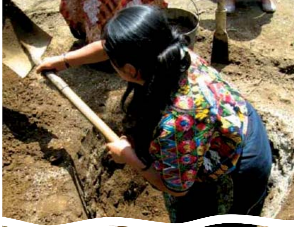
Participación de la mujer en el proceso de construcción de letrinas Canchagua, San Antonio Sacatepéquez, San Marcos
