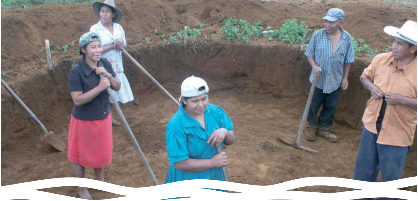
Beneficiarios de la comunidad de Quesuntega trabajando hombro a hombro en la construcción de su tanque de distribución
