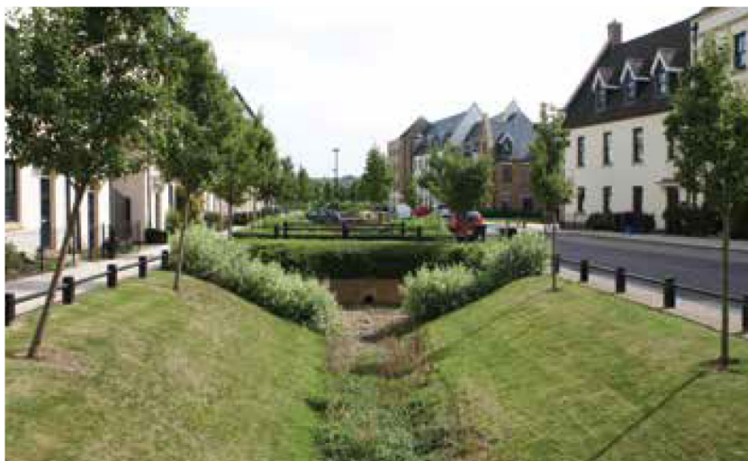
Figura 36: Shembull i kanaleve të cekta - sigurimi i funksionit të kullimit, por edhe mbajtja dhe korridori i bimësuar (CIRIA 2015).
