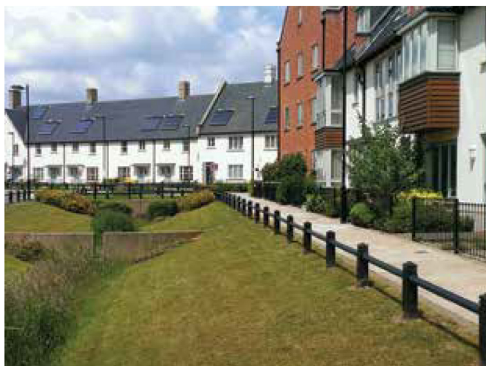
Figura 37: Kanal i cekët i thatë për kontrollin e rrjedhës (funksioni i mbajtjes), (CIRIA 2015).
