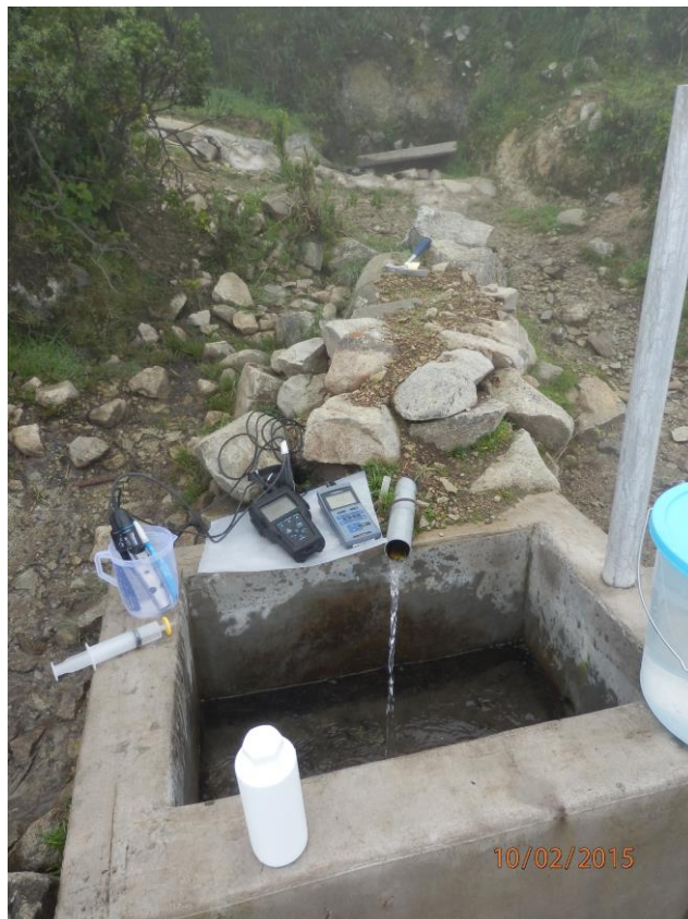
Fotografía 5 Manantial captado Sicacancha (1375544-189), cuyo aprovechamiento se produce en los fundos aledaños a la captación, tiene un caudal de 1.8 L/s (época de lluvias).
