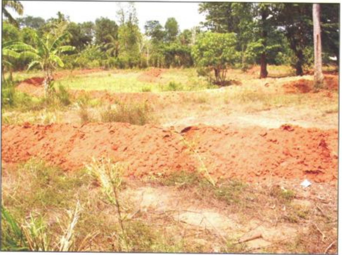
சமவுயரக் கோட்டு வரம்பு சரிவிற்குக் குறுக்காக நிர்மாணிக்கப்பட்டுள்ளது
