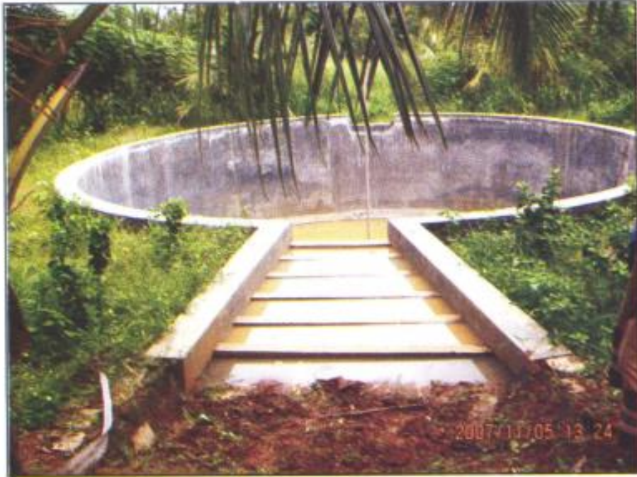
படம் ii: மழை நீரைச் சேகரிப்பதற்காக கொன்றீட் மேற்பரப்பு இட்டு நிர்மாணிக்கப்பட்ட ஒரு குளம்
