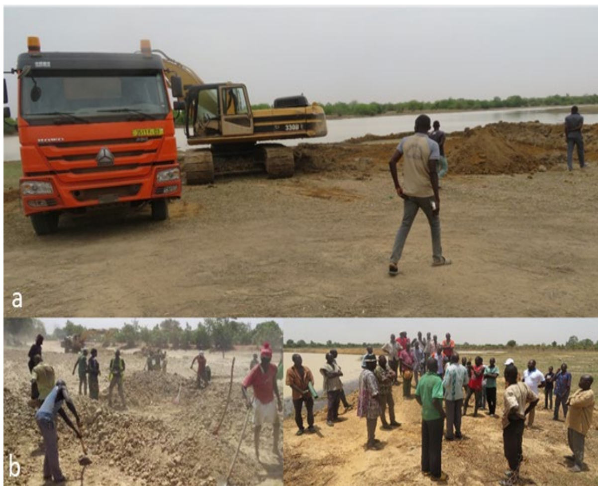
Photo 2.11.2.5.1. : a-Travaux mécanisés ; b-Travaux manuels de curage de la retenue d'eau de Kuela
