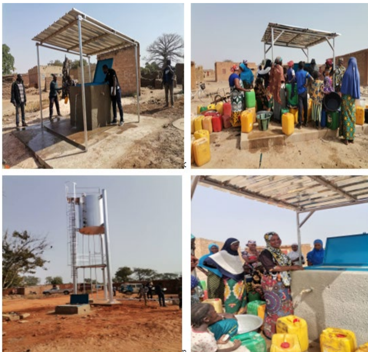
Photo 2.12.5.1. : Réalisation de 24 Postes d'eau autonomes (PEA) et de 7 mini AEPS dans 5 Régions pour un montant de 900 millions FCA, AEM
