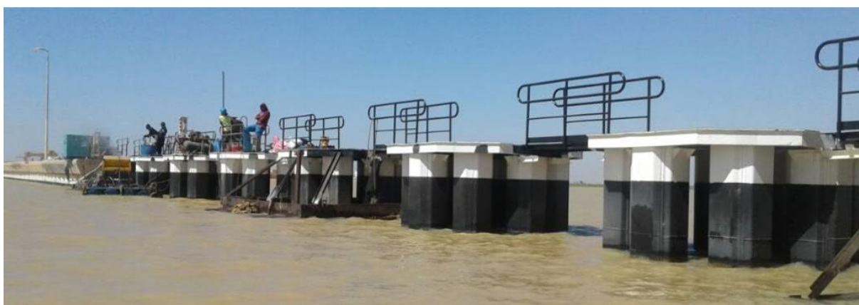
Photo 3.8.3.2. : Réfection de la protection passive du guideau et du duc d'albe amont du barrage de Diama
