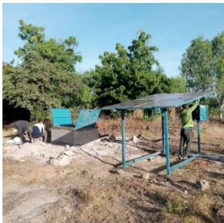
Photo 2.10.3.4.1. : Forage équipé d'un système d'exhaure solaire
