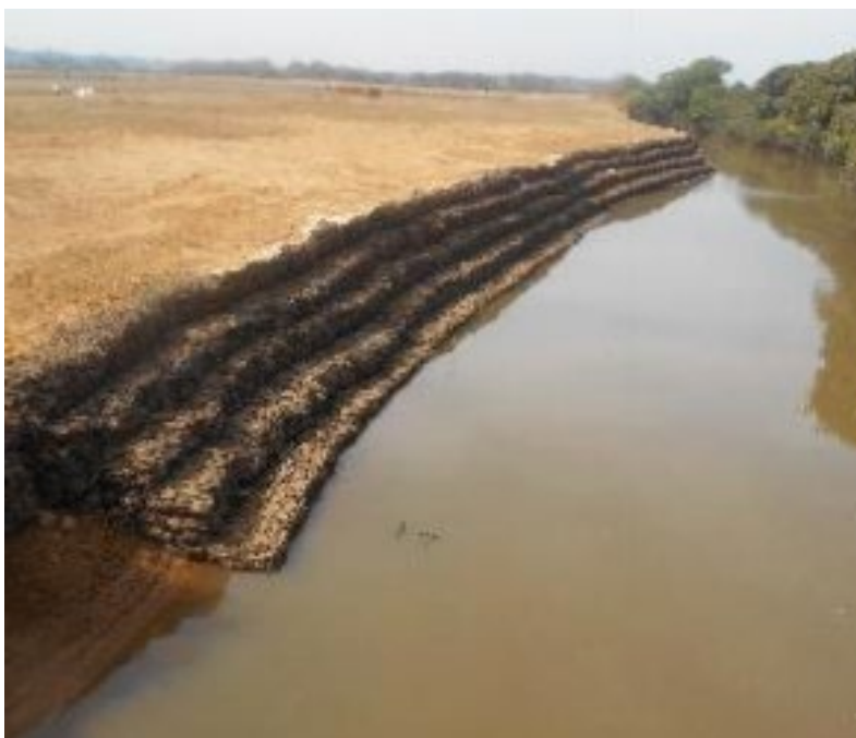
Photo 3.8.3.3. : Protection des berges à Dounet (Guinée)
