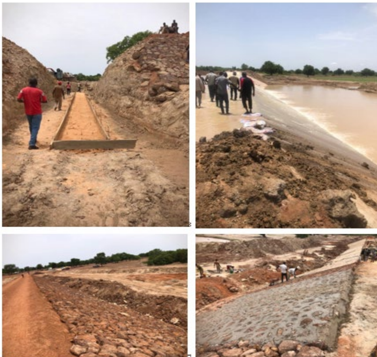
Photo 2.12.5.2. : Réalisation du barrage de Nanou (environ 1 milliard) AEM
