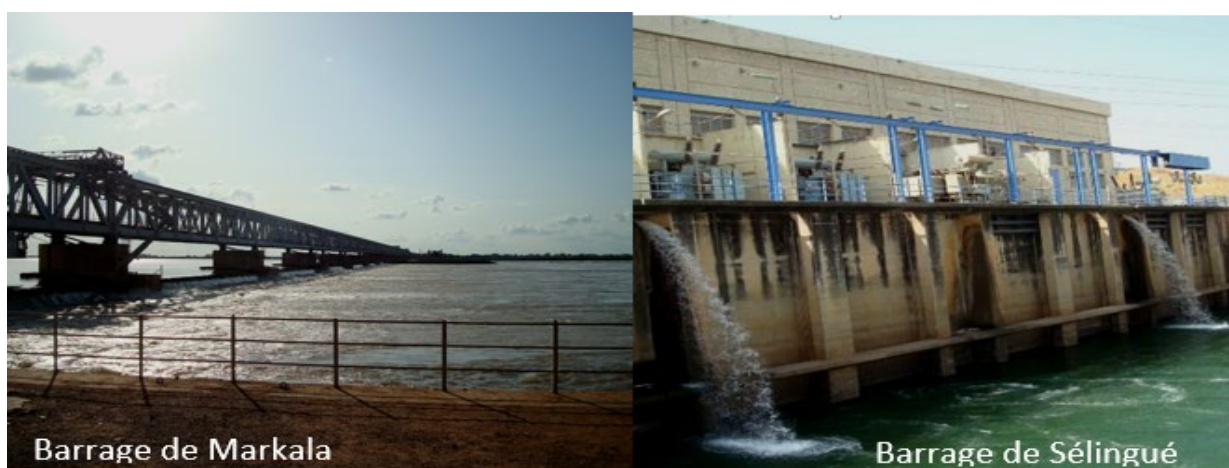
Photo 2.17.1.1.1. : Barrages de Markala et de Sélingué Source : Direction Nationale de l'Hydraulique du Mali
