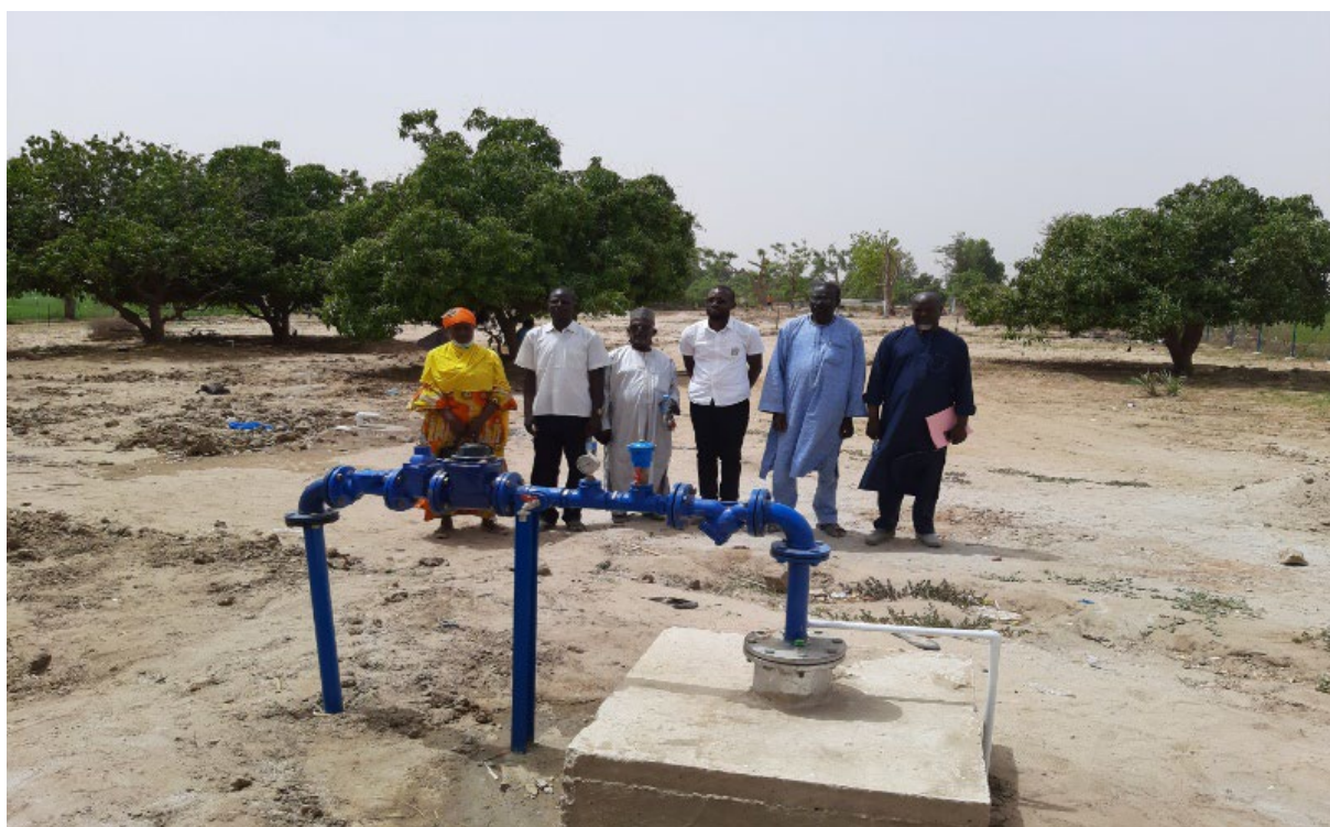
Photo 2.21.3.7. : Visite de l'équipe CNU-Niger ensemble avec le contrôleur des travaux en présence de l'entreprise sur une réalisation hydraulique du site
