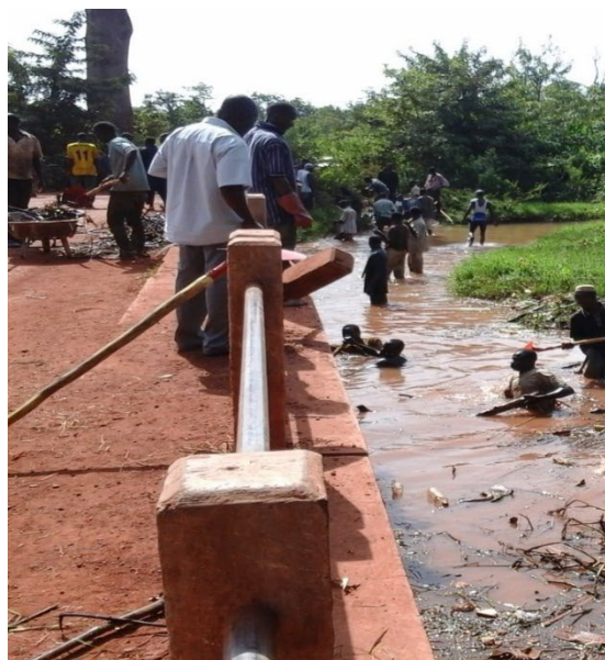
Photo 2.9.2.4.1. : Séances de curage du Pont de Nasso pour la prévention des inondations
