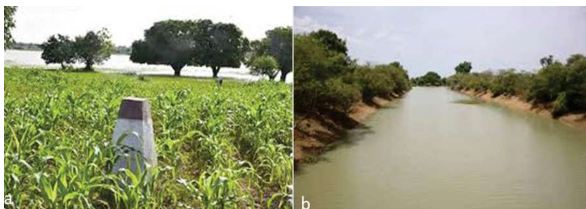
Photo 2.11.3.2.1. : Une balise matérialisant les limites de la bande de servitude (a) et la couverture végétale des berges protégées (b)
