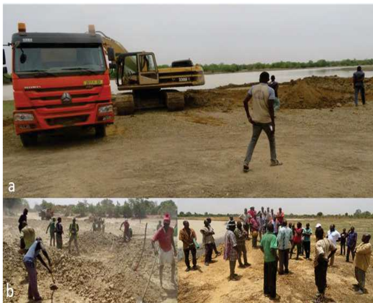
Photo 2.11.2.5.1. : a-Travaux mécanisées ; b-Travaux manuels de curage de la retenue d'eau de Kuela
