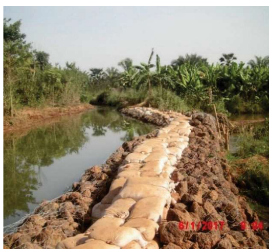
Photo 2.9.2.4.3. : Colmatage des brèches de la rivière du Kou
