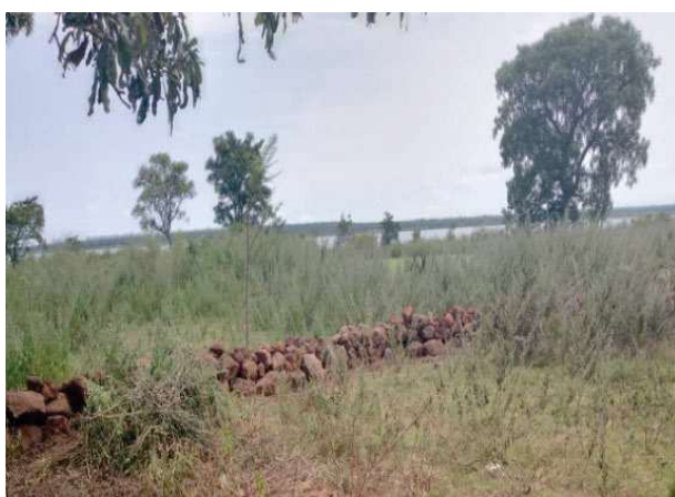
Photo 2.9.2.1.1. : Diguettes filtrantes
