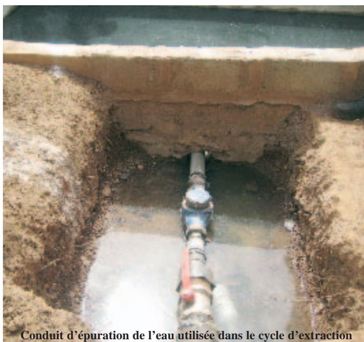
Conduit d'épuration de l'eau utilisée dans le cycle d'extraction
