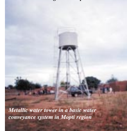
Château d'eau métallique dans le cadre d'un réseau d'adduction d'eau sommaire dans la région de Mopti
