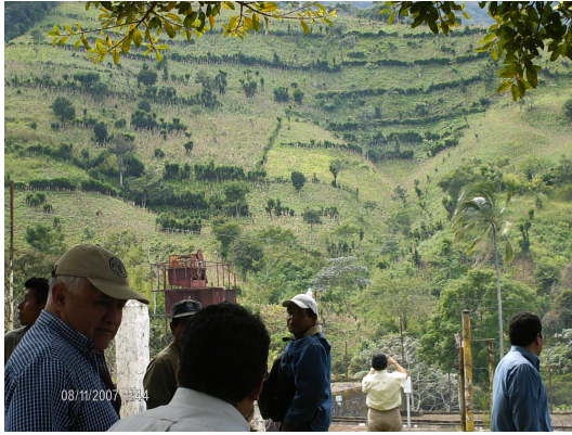
Construcción de barrera vivas
